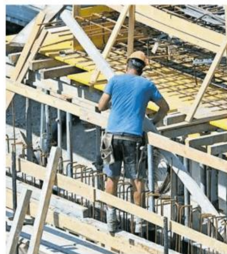
Un operaio edile al lavoro in un cantiere ANSA
